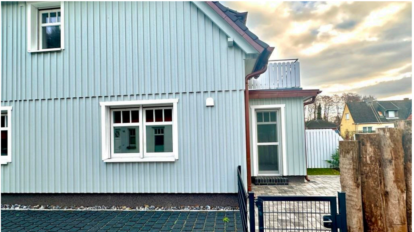
seitlicher Zugang zur Terrasse
