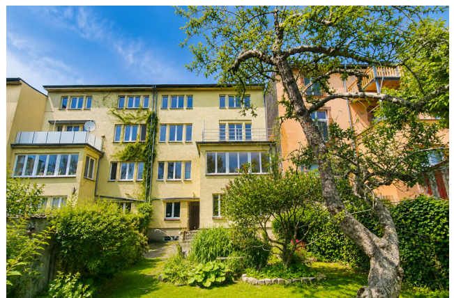
Gebäudeansicht von Hofseite
